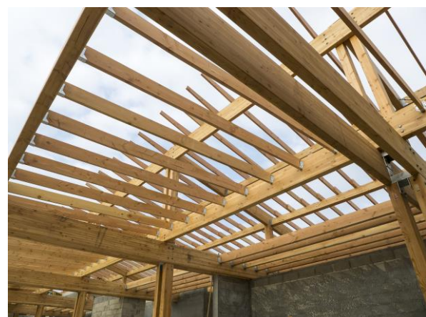
La charpente de la restauration scolaire (le 25/09/14)
