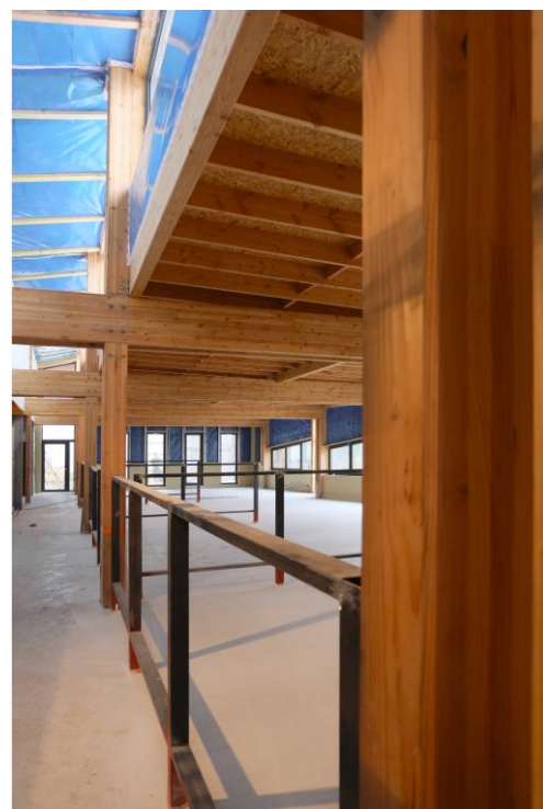
Intérieur du restaurant scolaire : ambiance chaleureuse grâce au bois apparent
