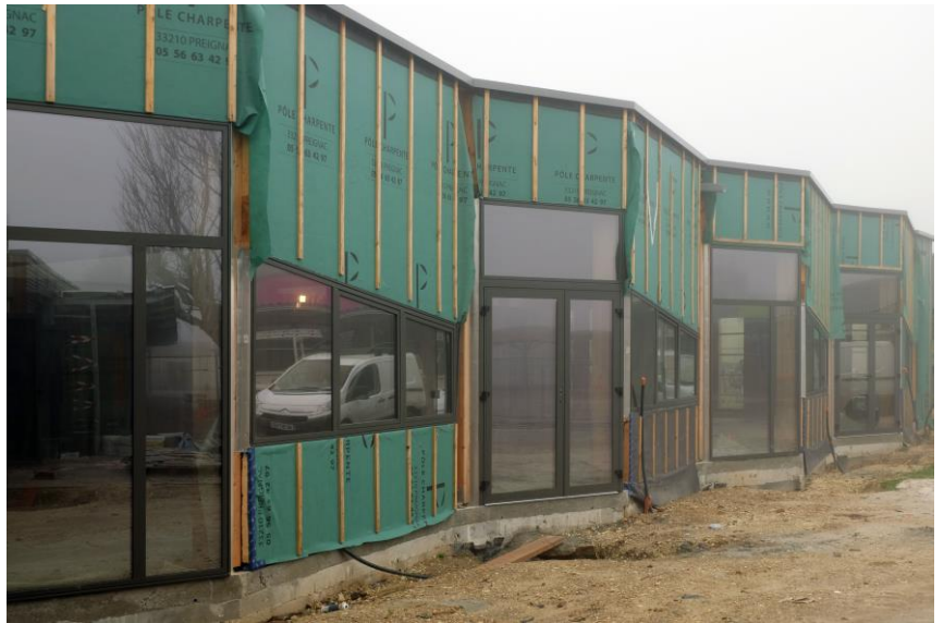
Menuiseries aluminium réalisées par une entreprise dyonisienne.
