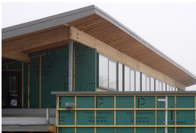
Restaurant scolaire : lumière naturelle grâce notamment au puit de jour sur le toit.
